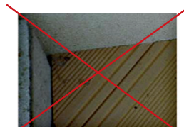
Zostawić 5-milimetrowy odstęp dylatacyjny między deskami oraz 15-milimetrowy odstęp od ściany
