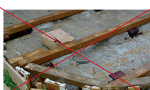
Zachować 10-milimetrowe złącza dylatacyjne między legarami
